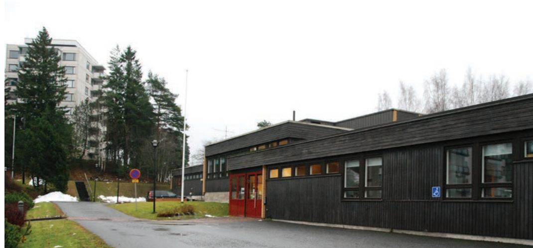
Rakennuksen pääsisäänkäynti ja julkisivu pohjoiseen.
